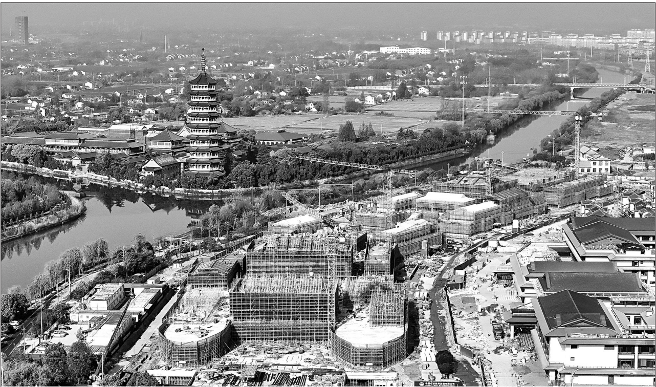
4月8日,位于江苏扬州经济技术开发区的“大运之舟”文商旅综合体施工现场,吊塔忙碌,数百名建设者正全力奋战,力争6月底全面竣工。项目建成后,将与周边景点联动,共同打造扬州南部文化旅游的新增长极。图为施工现场。
