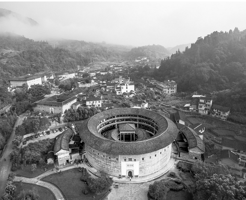
俯瞰洪坑村 福建土楼永定景区 供图
