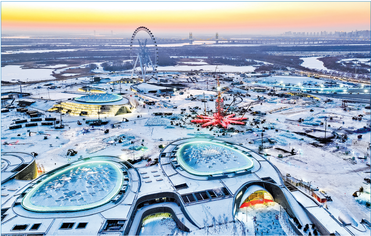
第二十六届哈尔滨冰雪大世界冰建施工热火朝天,根据计划,超级冰滑梯滑道将增加至24条,排队处新建近300米长的防风暖棚,此外在支付、餐饮、导览等方面均有提升,将为游客提供更优质的游玩体验,让大家尽享冰雪之美、冰雪之趣。图为近日航拍下的哈尔滨冰雪大世界施工现场一片忙碌景象。 视觉中国 供图
