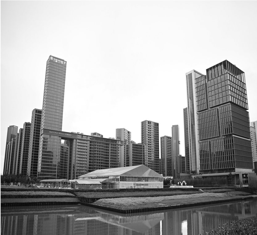
杭州亚运村外景 中新社记者 王刚 摄
