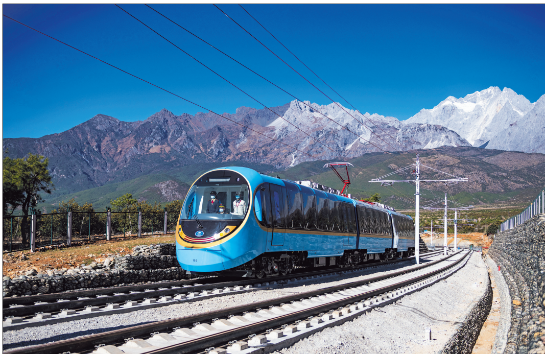
11月28日,丽江观光火车一期工程正式通车试运行,全长约20.8公里,是连接丽江古城与玉龙雪山的旅游观光专线。图为当日,观光火车行驶在丽江观光火车一期工程铁路线上,远处是玉龙雪山。陈欣波 摄
