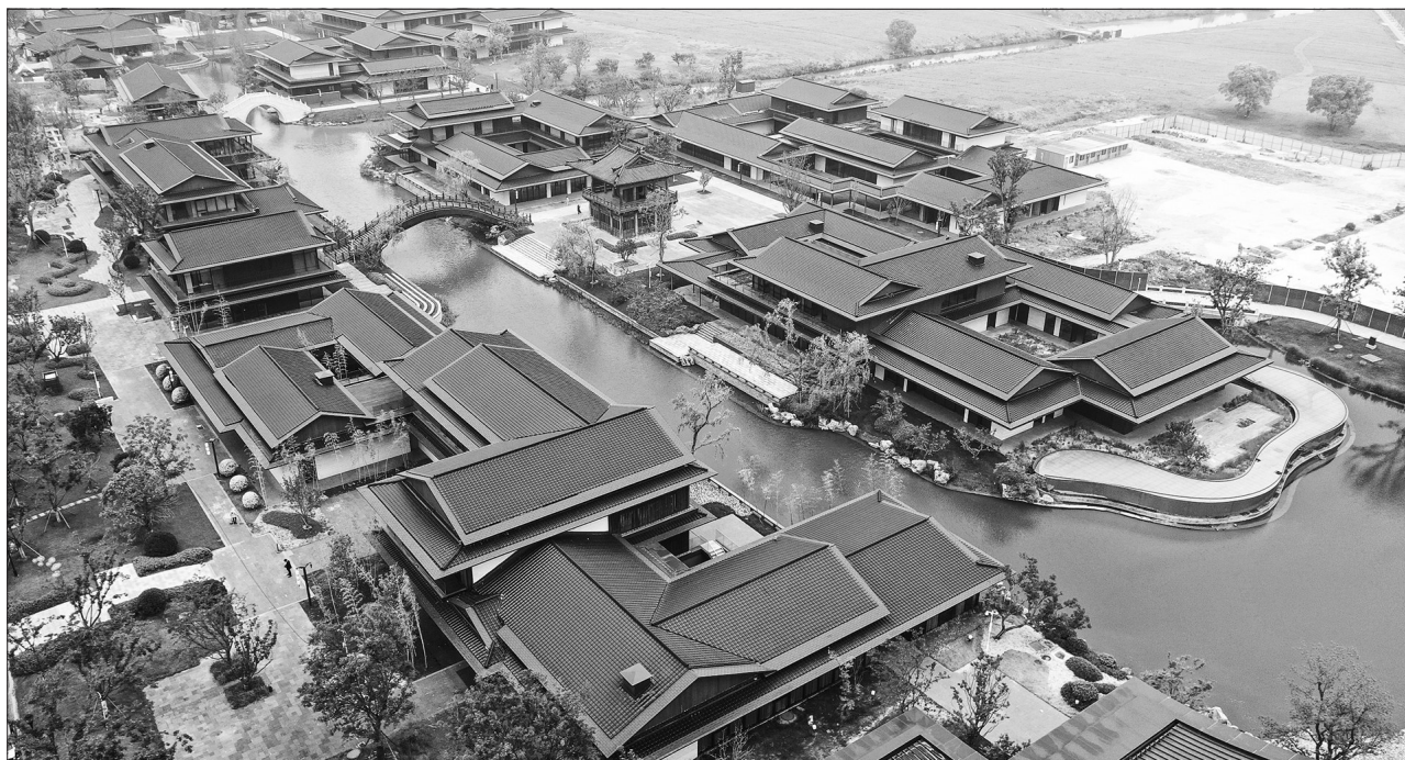
5月7日,中国大运河博物馆的配套项目、位于江苏扬州运河三湾的大运河非遗文化园一期工程主体建筑已全部完工。文化园内,庭院、长廊、小桥等仿古建筑错落有致,整体呈现大气质朴、飘逸舒展的唐韵风格。图为大运河非遗文化园风光。 齐立广 摄
