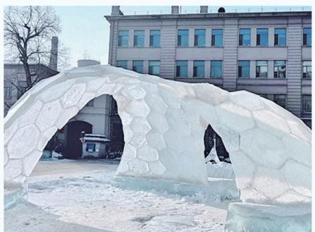
冰雪建筑以冰、雪为主要建造材料,抵御风寒,造型美观,可长期设置于室外低温环境,对于推动冬季运动与旅游经济发展,以及极地科考站建设、发展寒地建筑文化,具有重要的社会和经济价值。互动媒体设计与装备服务创新文化和旅游部重点实验室研发团队针对冰雪建造的技术手段进行提升,解决了参数化建模、三维壳体形态力学找形设计、竖向荷载有限元应力分析、性能目标下模型尺寸优化求解、网络拓扑剖分、数控加工制造等一系列关键问题,将多领域技术内容融合,将材料、力学、形式及建造结合,是将力学找形与数控建造一体化协同方法应用于冰雪建造。该案例体现了计算性设计理论在综合考虑建筑形态、结构与建造需求,挖掘出不同地域气候与建筑材料潜力方面的创新能力。
