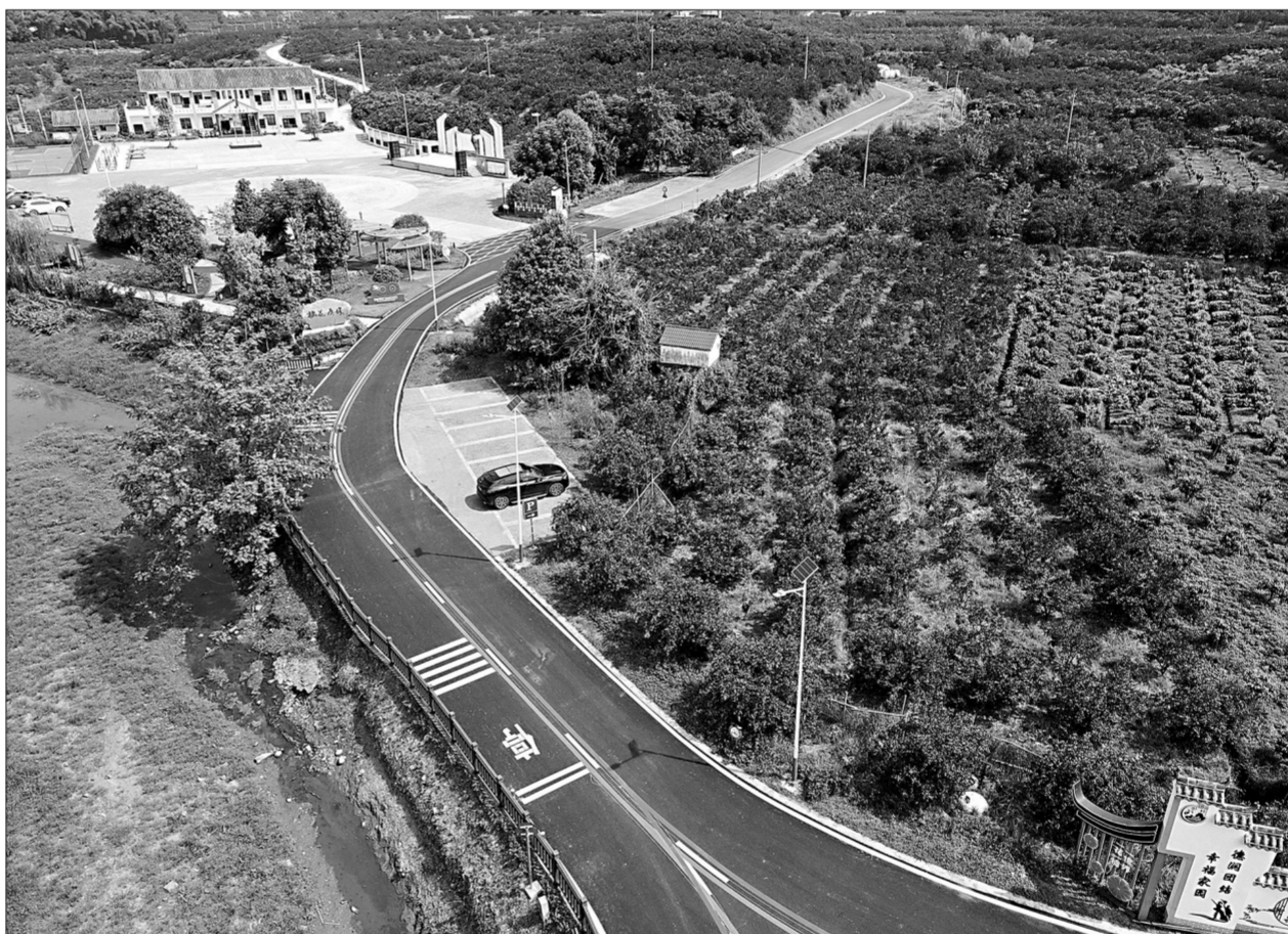
8月16日,在四川省眉山市彭山区团结村干净整洁的村道上,大小车辆来来往往。一条条通畅、安全、舒适、美丽的农村公路成为彭山区一道道美丽的风景线。近年来,该区累计投入10亿元用于“四好农村路”建设,新改建脱贫路、产业路、旅游路、畅通路86条300多公里。图为当日航拍的团结村村道。 翁光建 摄
