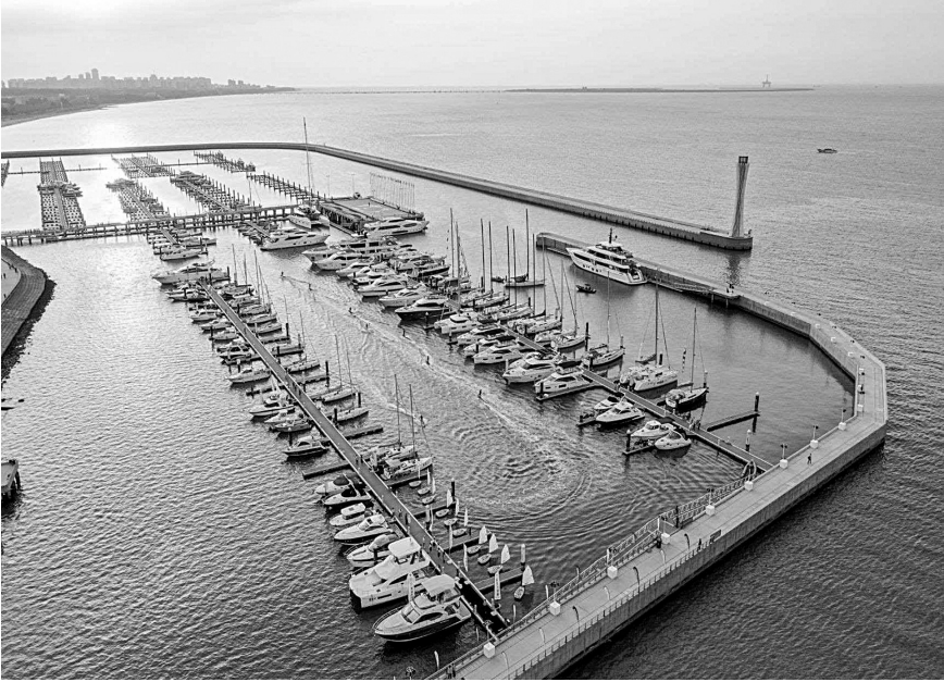
海口市国家帆船基地公共码头 海口国际投资促进局 供图
