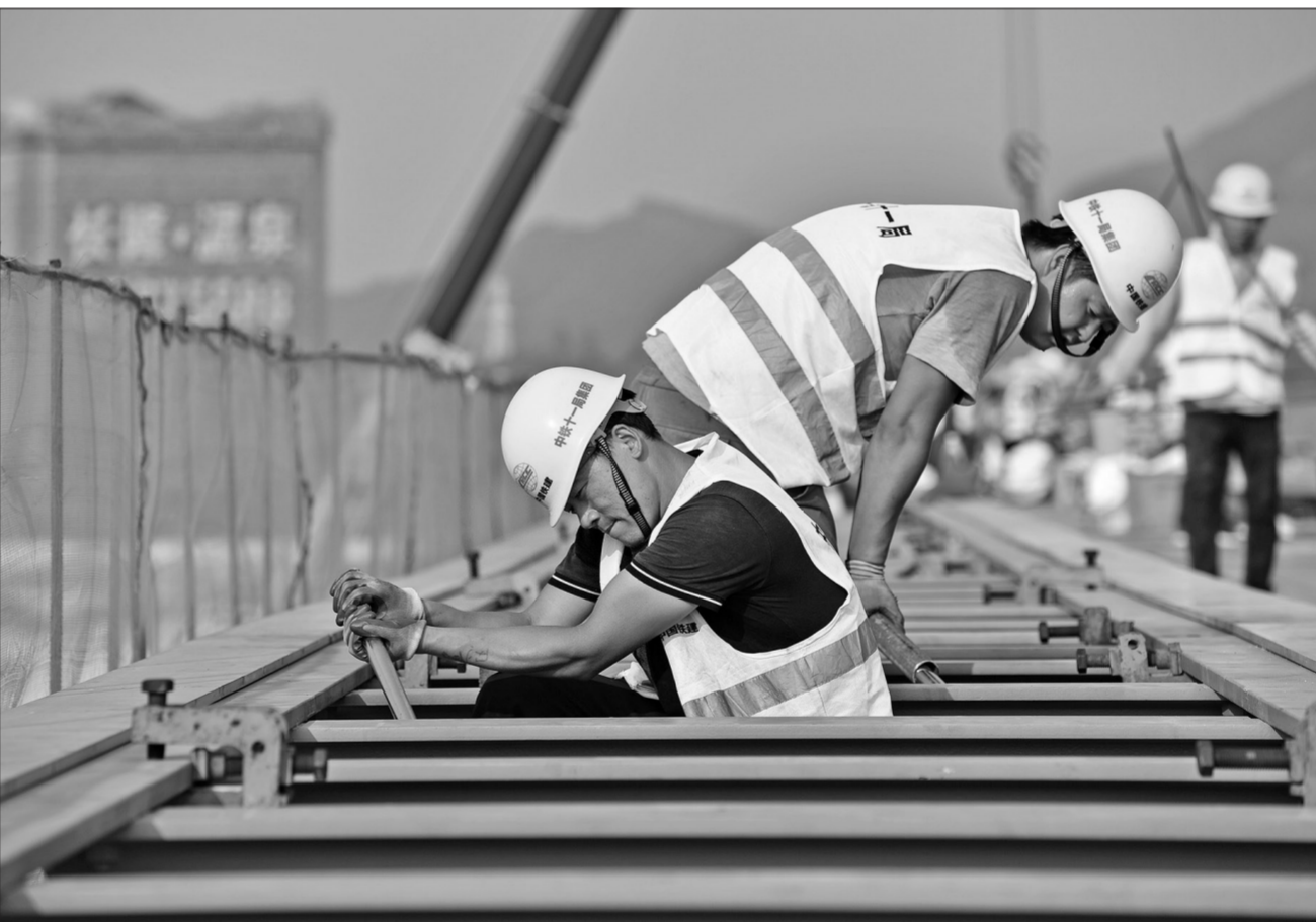
9月2日,中铁十一局施工的广东清远磁浮旅游专线开始铺轨。该旅游专线是广东首条中低速磁浮线,项目首期全长8.014公里,预计2020年底实现主体工程全面完工。图为当日,施工人员在铺轨现场进行扣件紧固作业。
